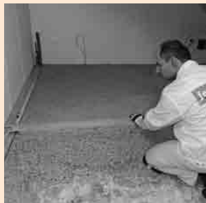
Comblir l'espace entre les deux digues avec du mortier d'égalisation
