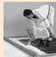
Epandre les granules d'égalisation
