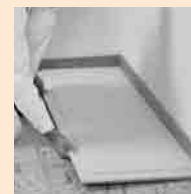
Posez les plaques de sol FERMACELL
